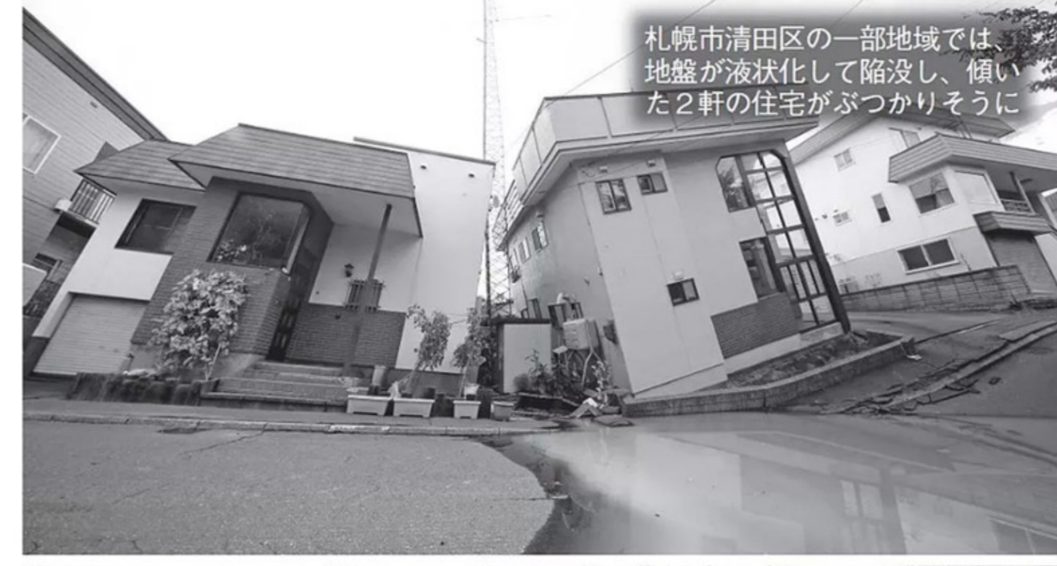
液状化により波打った道路。平坦だった道路は地震で一変。液状化した泥土が噴出した
